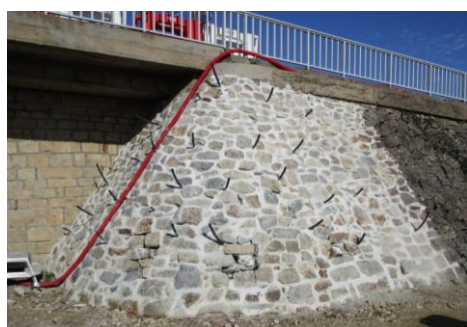
Stabilisation des enrochements
