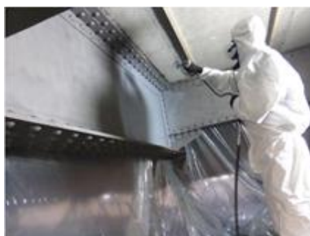
Décapage et remise en peinture de la structure métallique
