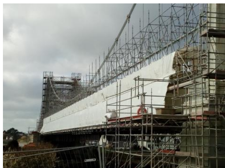
Echafaudages sur le Pont Lorois
