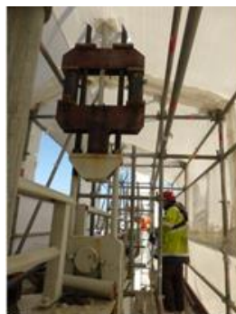
Test préalable au changement des suspentes
